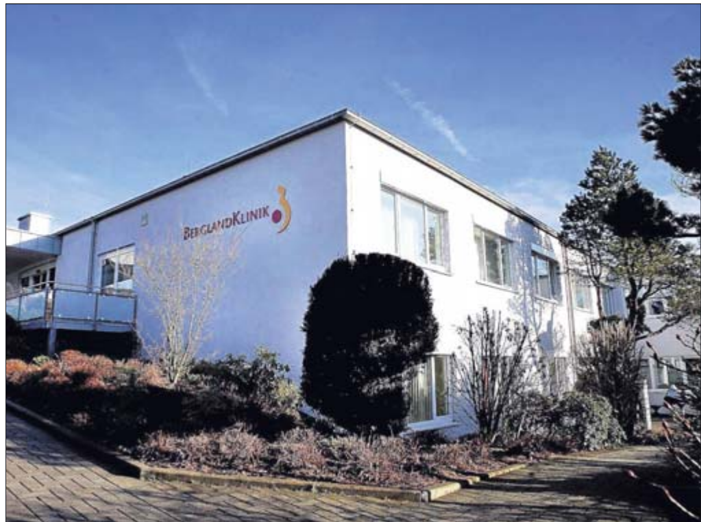
Die Berglandklinik am Hundebrink: Sie ist seit mehr als 40 Jahren eine Adresse für Gynäkologie und Geburtshilfe. Zum 40. Geburtstag 2012 wurden umfangreiche Sanierungsmaßnahmen beendet.
